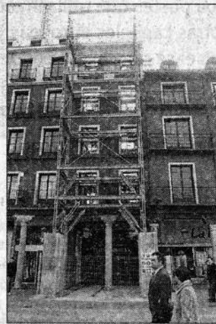
Uno de los andamios del teatro.
